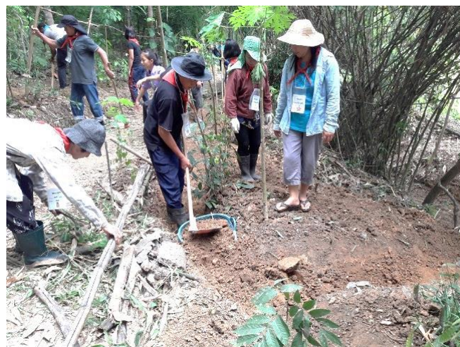
กิจกรรมฝึกชุดคลองไส้ไก่ ความลึก ความกว้าง 50 x 50 เซนติเมตร
