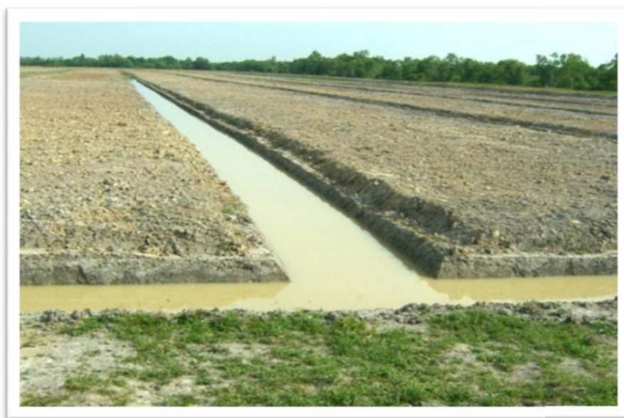
ภาพที่ 2.5 ร่องระบายน้ำในสวนปาล์มน้ำมัน
