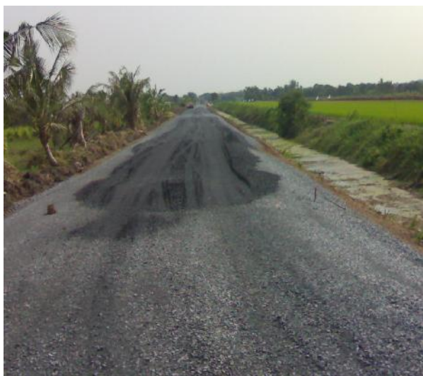
ก่อสร้างถนนลาดยาง สายหมู่ที่ 3 ตำบลคลองนครเนื่องเขต อำเภอเมือง จังหวัดฉะเชิงเทรา ระยะทาง 1.400 กม.
