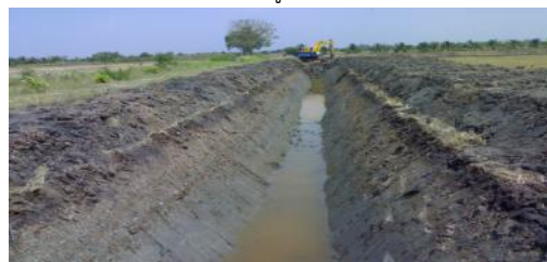
ชุดคลอง และ ชุดลอกคลอง 4 สาย ระยะทาง 4.719 กม. ตำบลคลองนครเนื่องเขต
