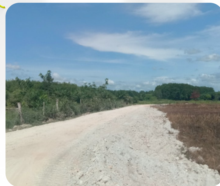
ก่อสร้างถนน
