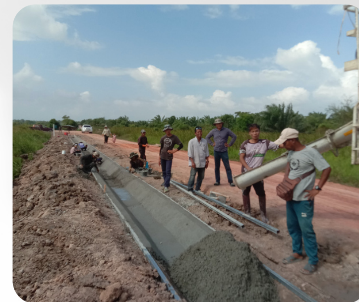
ก่อสร้างคูส่งน้ำ
