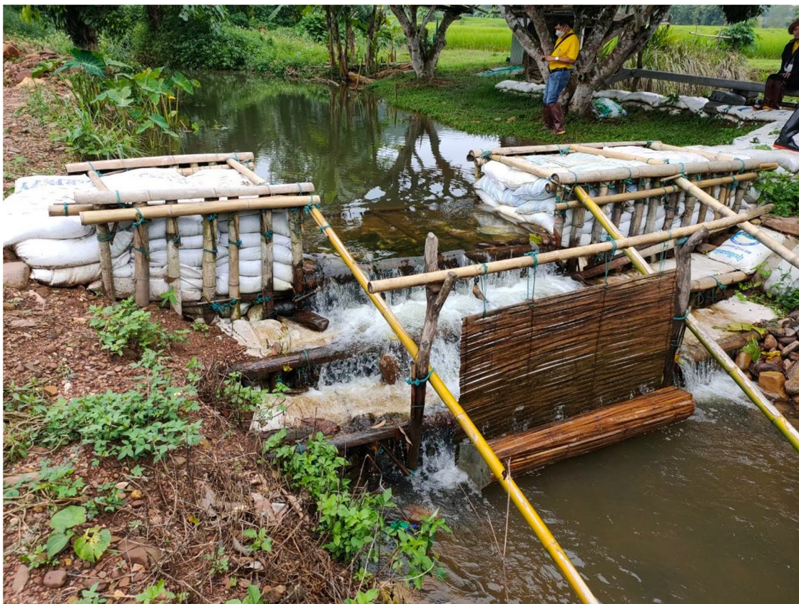
รูปภาพที่ 2.2 รูปแบบฝายชะลอน้ำ ส.ป.ก.
