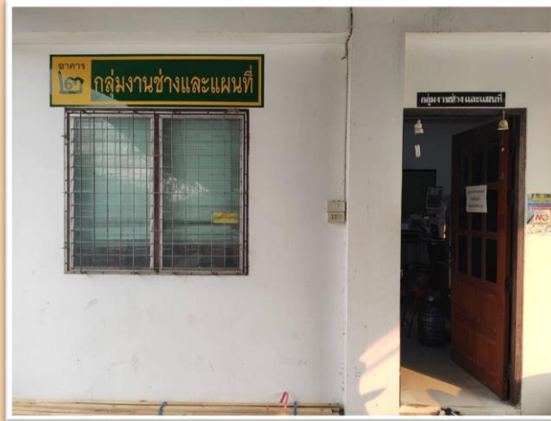
อาคารกลุ่มงานช่างและแผนที่
